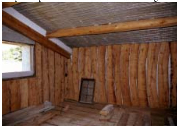
Cloisons en planches de Pin d'Alep contre lesquelles sera projeté du plâtre maintenu par un grillage métallique. Intérieure d'une chambre d'un futur gîte à Tourtour (Var).
