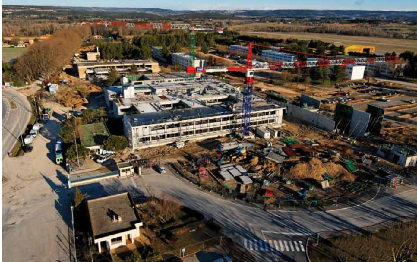
Le pôle pédagogique en quelques chiffres : 18 000 m 2 de surface, 450 chambres, 1 000 repas par jour, bureaux pour 200 personnes, 30 salles de cours, 2 amphithéâtres, 1 stade, 1 gymnase.
