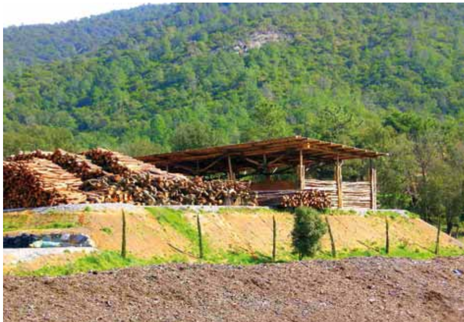
Hangar du Sivom du Pays des Maures et de St-Tropez sur la plateforme de la Môle dans le Var.
