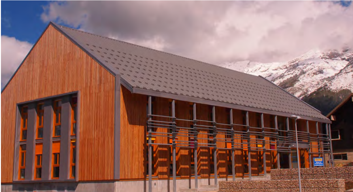
Maison de Territoire du Conseil Général de l'Isère à Villard de Lans (38)
