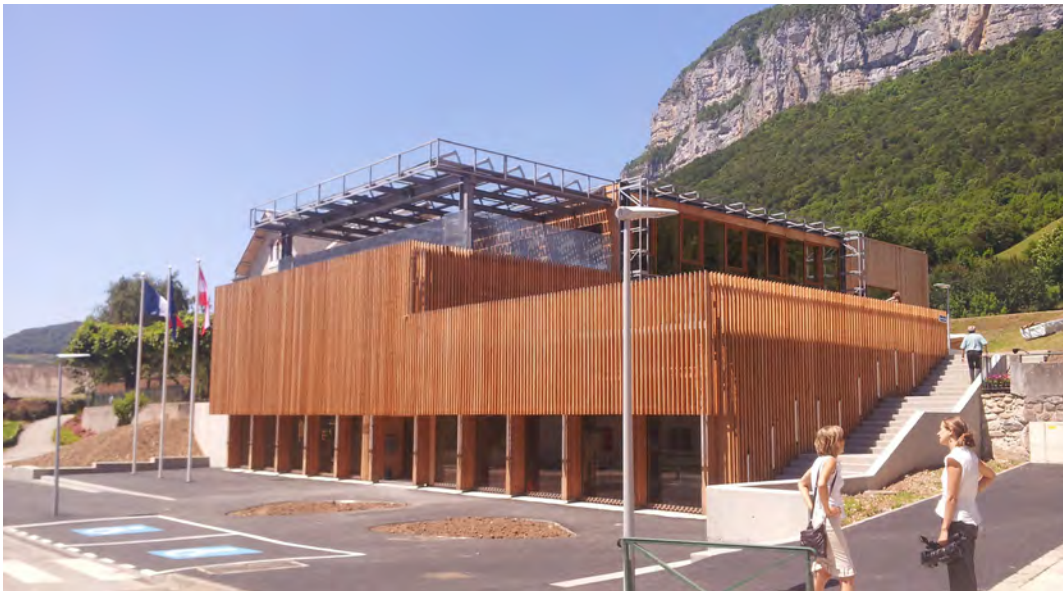
Le bâtiment multifonctionnel en bois local de St Jean d'Arvey (73)
