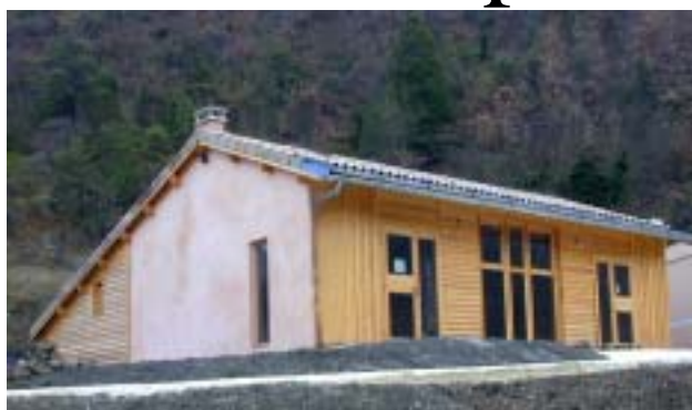
Maison à ossature bois dans la Drôme avec des murs crépis et du bardage bois. Photo Catherine Bourgeois
