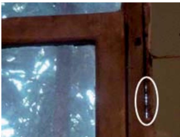
*Ici, que la fenêtre soit performante ou non, c'est par le joint latéral entre le châssis dormant et le mur qu'il y aura des pertes de chaleur.*
