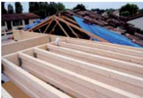
*Création d'un plancher en surélévation partielle avec mise en place d'un porteur BLC et de solives en poutres en I
