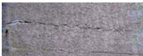
Ainsi, la présence de fissuration doit alerter l'entrepreneur sur la potentielle infiltration d'eau au sein de la paroi. Après analyse de la cause (déformation/tassement, problème d'application du revêtement...), la réparation des dommages doit être engagée.
